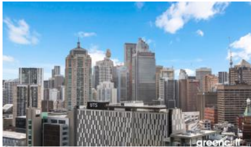
E2110, 3 Carlton St, Chippendale
